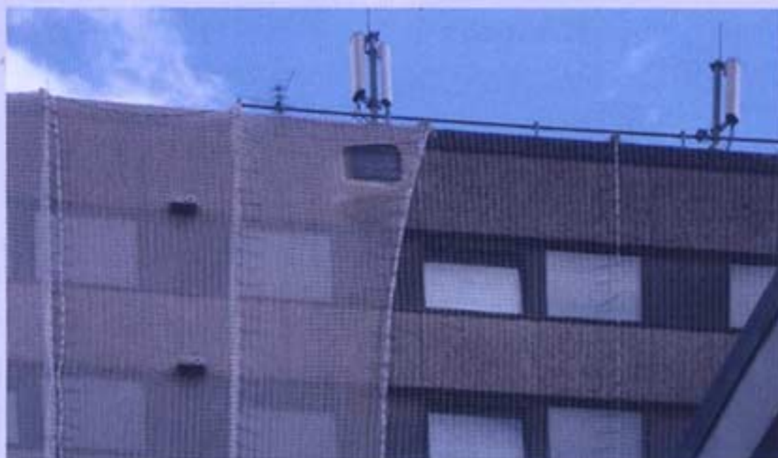
Stabilisierende Sofortmaßnahme: Fassadenplatten sicherungsvernetzt
